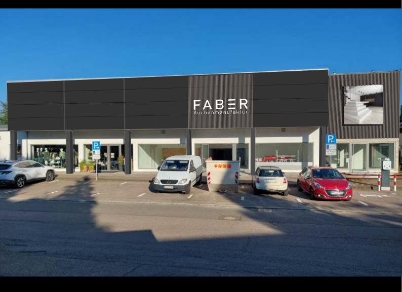
**Konzept:** Aluminiumfassade 25 x 4 m, mit Polyurethan Farbe in anthrazit lackieren. Eingangsbereich und Anbau, mit vertikalen Douglasienbalken in Mooreiche geölt, aufwerten. Mit Möbelbeschläge "unsichtbar" befestigt, das zusätzlich noch einen schwebenden Eindruck vermittelt. FABER logo silber in LED Deluxe Ausführung, mit nach hinten abgestrahlter Beleuchtung. Bei unserem FRAMELESS LED Leuchtrahmensystem können die Motive ohne großen Aufwand ausgetauscht werden.
